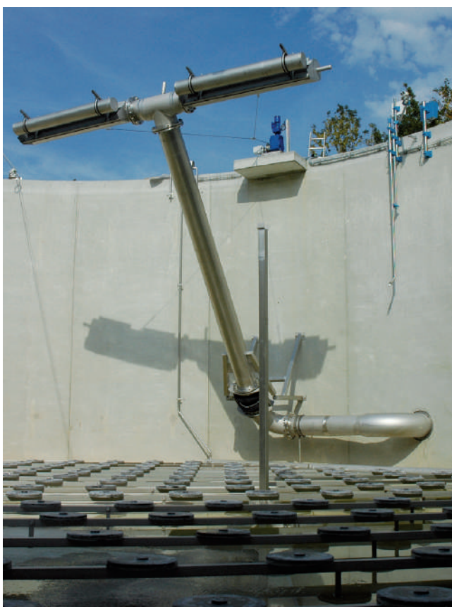
Декантер в комбинации с дисковыми аэраторами ELASTOX®-T.
