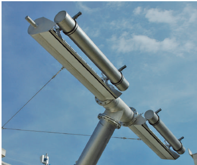
Труба забора очищенной воды декантера SBR-DEKA
