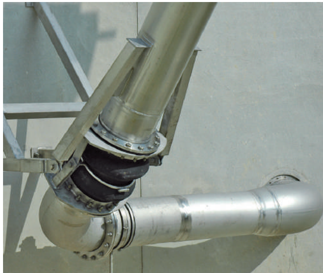
Колено между отводной трубой и декантером SBR-DEKA
